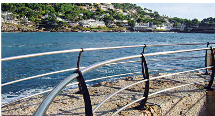
Merivesipärskeet voivat aiheuttaa suolakerääntymää läheisiin ruostumattomasta teräksestä valmistettuihin rakenteisiin. Voimakkaammin seostettu teräslaji sekä sileä pinta estävät värjäntymistä.
