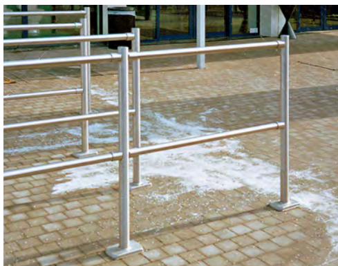
Molybdeeniseostettujen lajien käyttöä suositellaan alueilla, joilla käytetään tiesuolaa.
