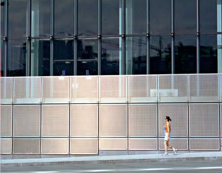
Satiinihiottu ja rei'itetty ruostumaton teräs säilyttää sille ominaisen hohdon Charlemagne-rakennuksessa Brysselissä Belgiassa.
