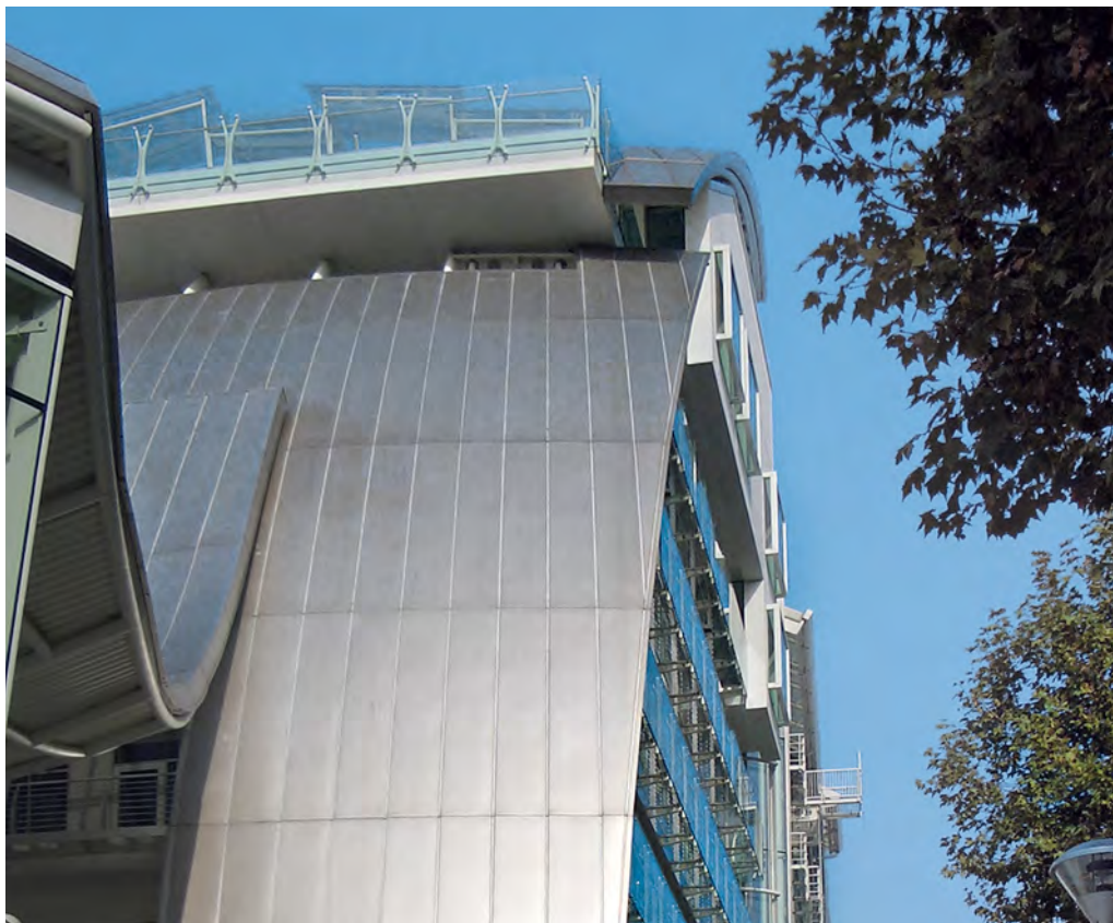
Sadevesi puhdistaa sää- oloille alttiit rakennuksen kuoren osat. Valokuva: Centro Inox, Milano, Italia
