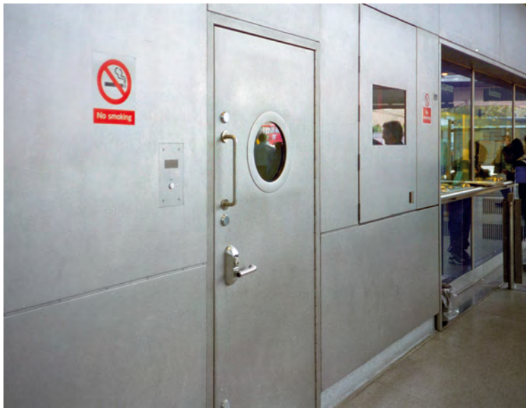
Suihkupuhallettu ruostu- maton teräs on osoittanut mekaanisen kestävyys- tensä avoimessa paikassa Southwarkin metroase- malla (Iso-Britannia).
